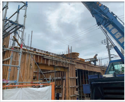
型枠建込作業中
