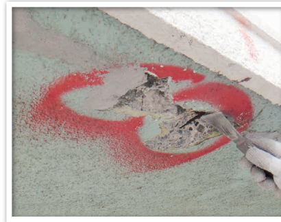
▲ 欠損・曝裂
