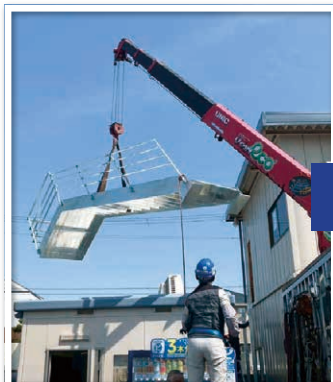
鉄骨外階段取り付け
