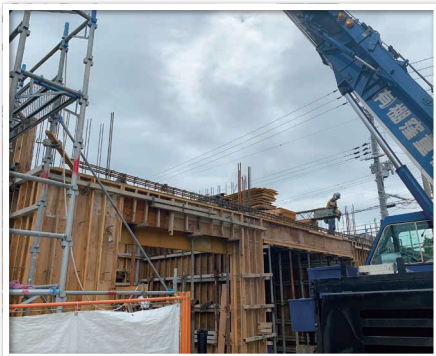
型枠建込作業中
