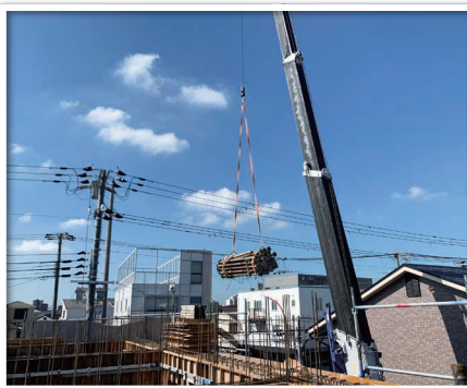
型枠建込作業中
