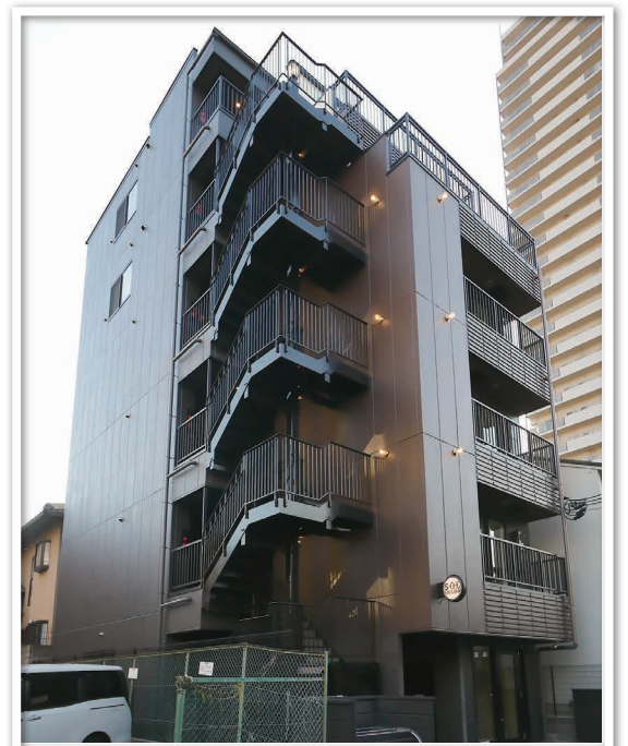
所在地：西宮市池田町 ▶ 構造：鉄骨造6階建 (2020年2月竣工)
